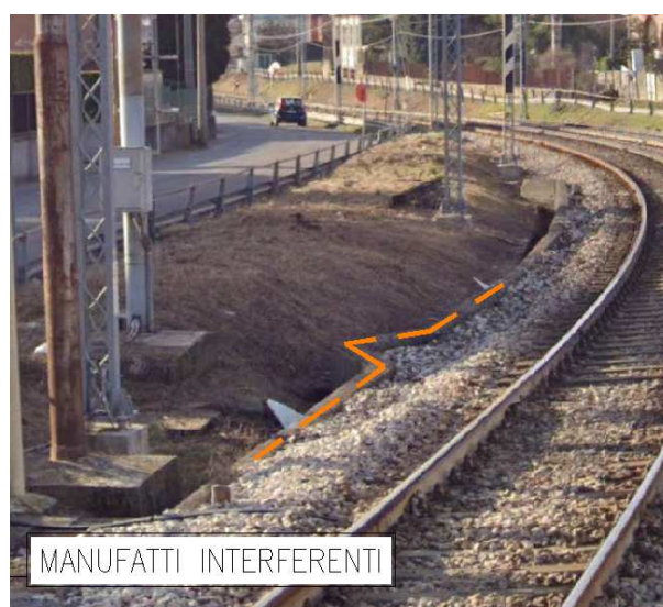
Figura 4 – Vista in arancione della canaletta cavi FS lato via alla Fonte
